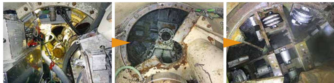
φ1,000mm 機内ビット交換状況
