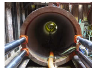
推進管内状況
