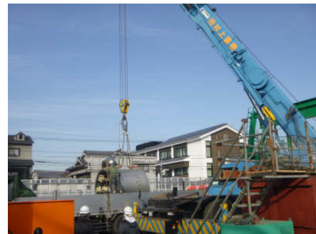
掘進機搬入状況
