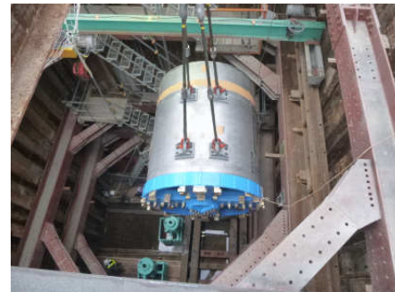
掘進機吊り降り状況
