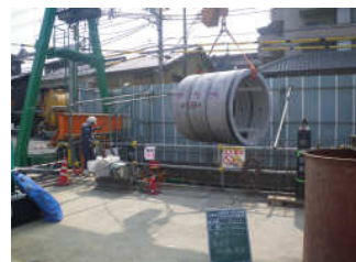
推進管吊り降り状況
