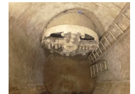
掘進機到達状況
