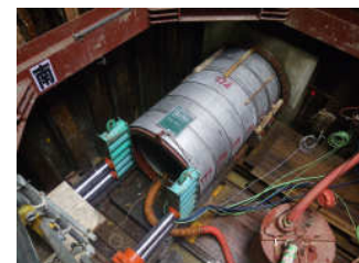
推進管設置状況
