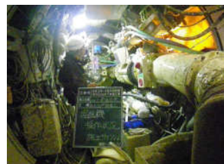
掘進機操作状況
