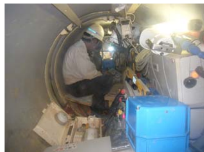
掘進機操作状況
