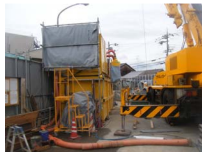
作業基地状況
