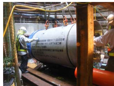
掘進機据付状況
