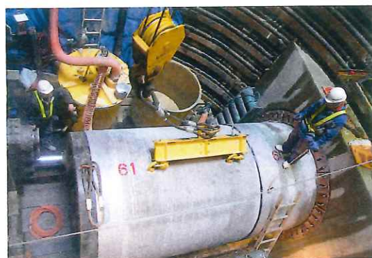
写真-2 立坑内の丸タンク
