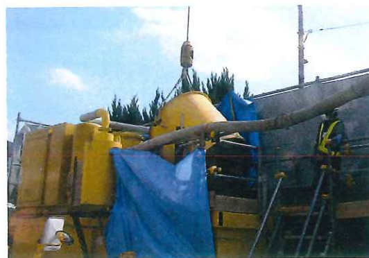
写真-3 立坑上の排土貯留槽
