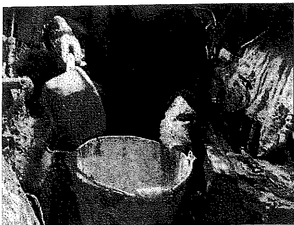
写真-1 掘進機内での排泥採取状況
