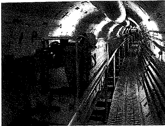
写真-7 バキューム台車運搬状況
