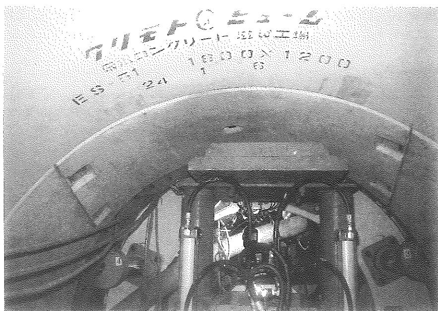
写真-1 推進管とセグメント接続状況
